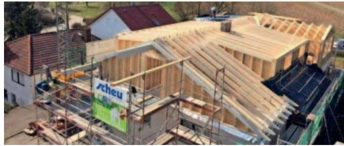
Wird eine Wohnraumerweiterung in Form einer Dachaufstockung ausgeführt, kümmert sich die Firma um alle Arbeitsschritte
